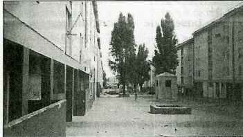
Os respiradores das mães de água na Rua da Mãe de Água na Buraca. O pitoresco da rua só aberta a peões.
