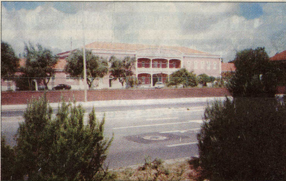
Vista parcial da Av.ª Conde de Castro Guimarães, tendo como pano de fundo a Academia Militar.
