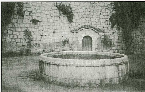
Um dos tanques da Fonte das Avenças.
