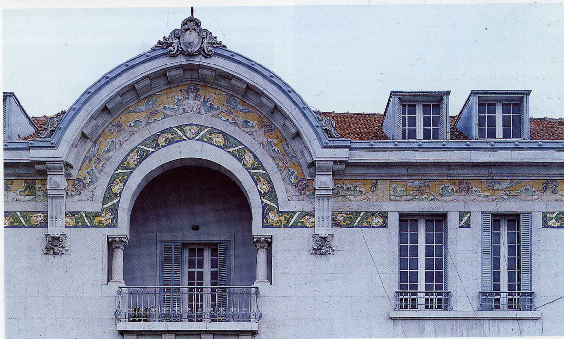
>> 12. Edifício de habitação, Rua Alexandre Herculano, Lisboa, 1903. Pormenor de frisos de azulejos de remate. Ventura Terra
