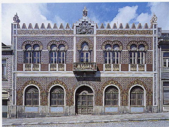
> 16. Fachada neo-mourisca do prédio da Rua José Falcão, Porto, c. 1900.
