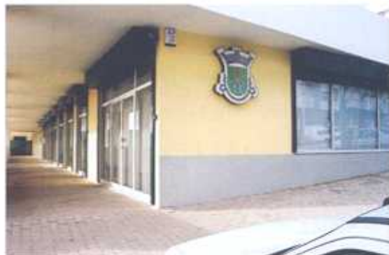
Aspecto exterior das instalações.
