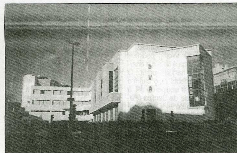
O «novo edifício» dos soldados da paz. Os BVA merecem o apoio de todos os amadorenses.
