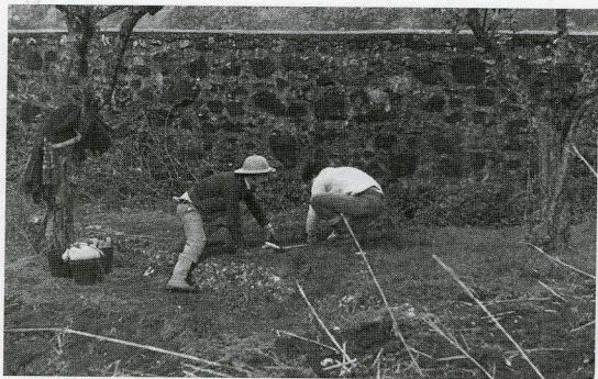
Fig. 1 - Intervenção no Aqueduto Romano pelo GAPROPA, tendo o Aqueduto das Aguas Livres do séc. XVIII por pano de fundo.
