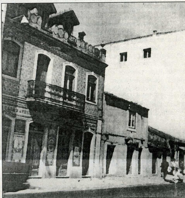
Casa do "Pedro dos Coelhoos" já demolida.
